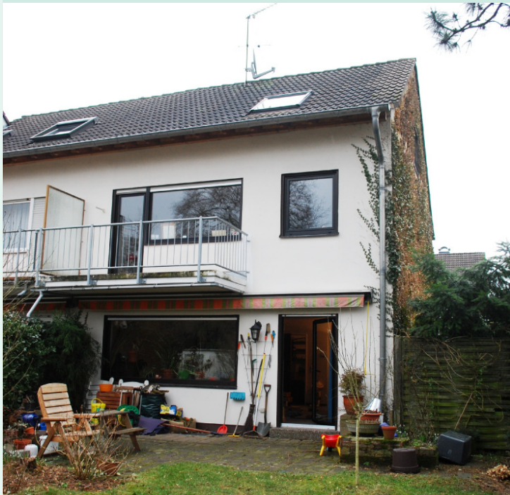
Vor der Sanierung
