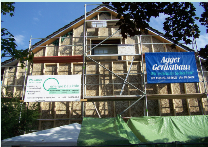
Dämmarbeiten an der Giebelwand
