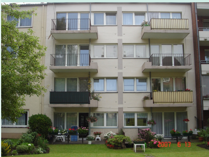
Gartenansicht vor der Sanierung
