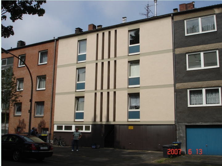
Straßenansicht vor der Sanierung
