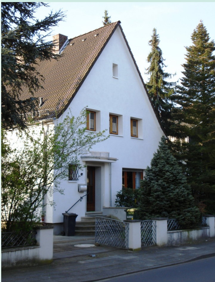
Straßenansicht nach der Sanierung
