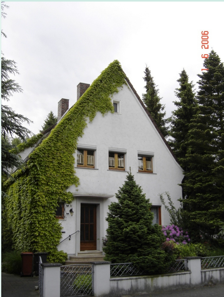
Straßenansicht vor der Sanierung
