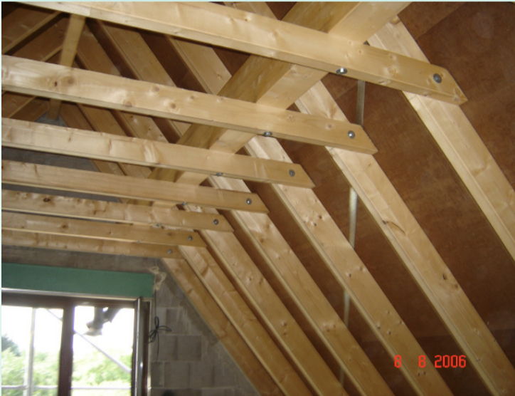
Holzfaserdämmplatten als Unterdeckplatten auf einem neu errichteten Dachstuhl
