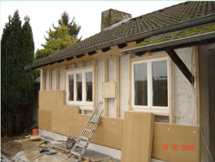
Anbringen eines Wärmedämmverbundsystems (WDVS) aus Holzfaserdämmplatten auf Kanthölzern, der Zwischenraum wurde später ausgeflockt.
