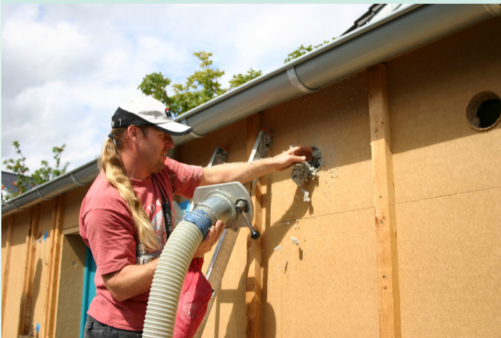
Bauhandwerker von energie bau köln GmbH beim Ausflocken einer Wand.
