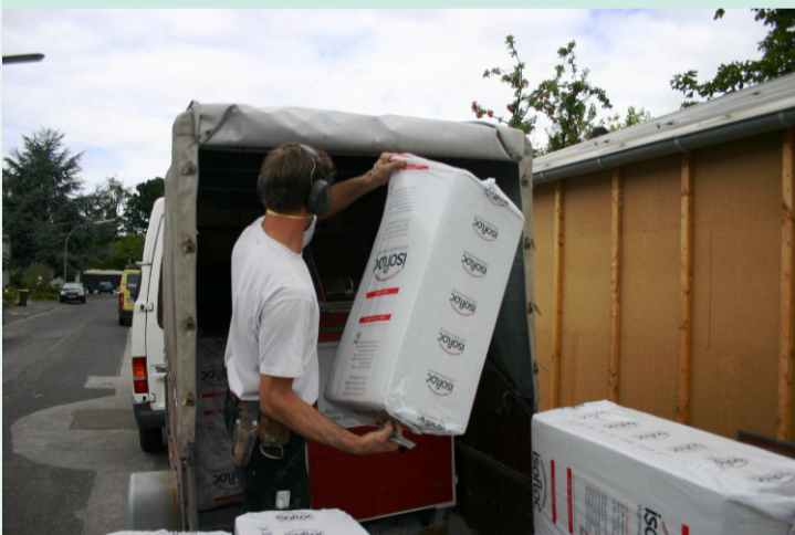
Ein weiterer Bauhandwerker füllt das isofloc vor dem Haus in den Flocker.
