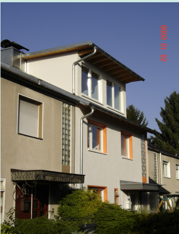
Nach dem Umbau - Eingangsseite
