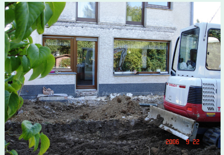
Gartenansicht vorhandenes Einfamilienhaus
