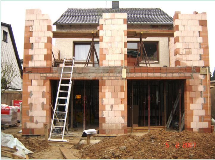
Der Anbau in porosierten Ziegeln im Bau
