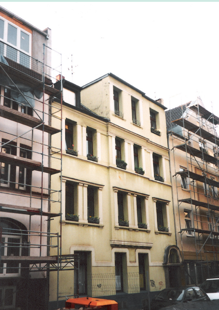
Das Gebäude nach und vor Durchführung der Baumaßnahme
