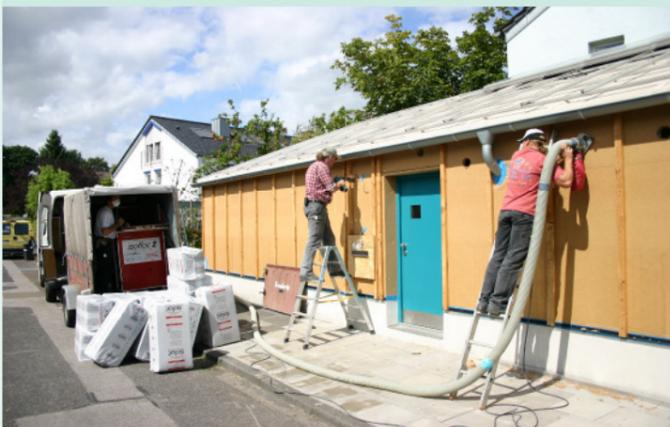
Einblasen des Isofloc-Zellulosedämmstoffs
