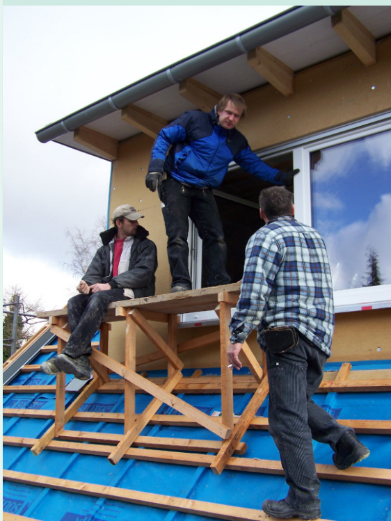
Während der Bauzeit
