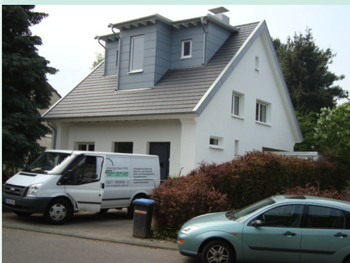
Nach Durchführung der Umbau- und Sanierungsmaßnahmen
